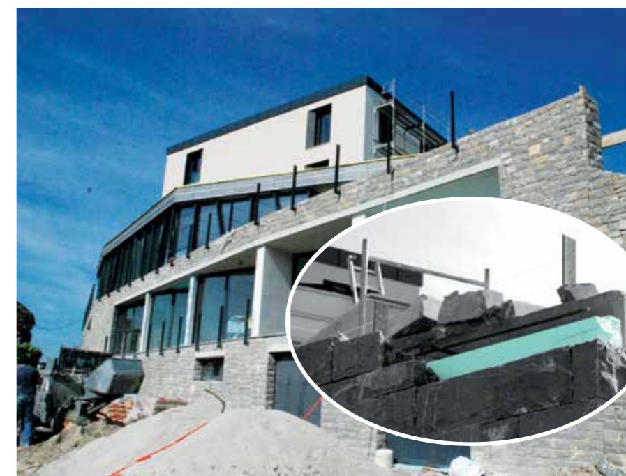
Facciata in pietra naturale di un albergo realizzata con pannelli portanti FIBRANxps ETICS BT sui quali è stato applicato il rivestimento pesante
