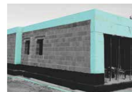
Isolamento di ponti termici, connessioni antisismiche e travi portanti con pannelli FIBRANxps ETICS
