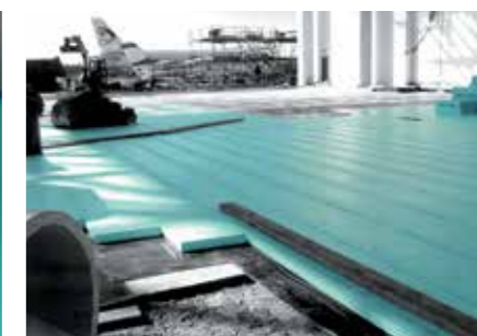
Protezione antigelo delle pavimentazioni degli hangar aeroportuali con FIBRANxps 700-L
