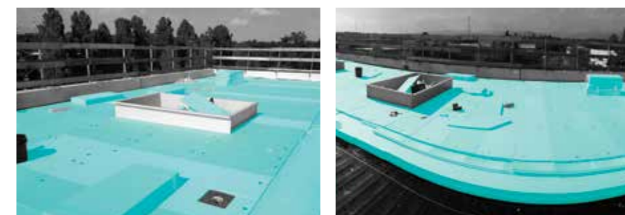
Realizzazione dell'inclinazione con pannelli FIBRANxps INCLINE e fissaggio di pannelli FIBRANxps su un tetto privo di protezione pesante
