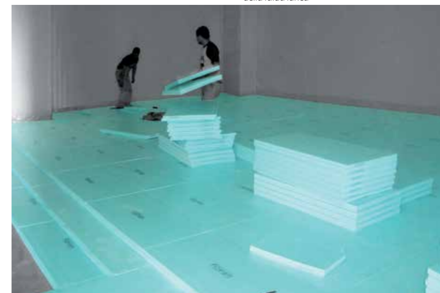
Pannelli termoisolanti FIBRANxps 300-I con bordo dritto studiati per sistemi a più strati.
