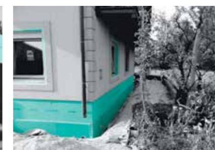
Isolamento termico dei ponti termici delle spallette e della zoccolatura con pannelli FIBRANxps ETICS
