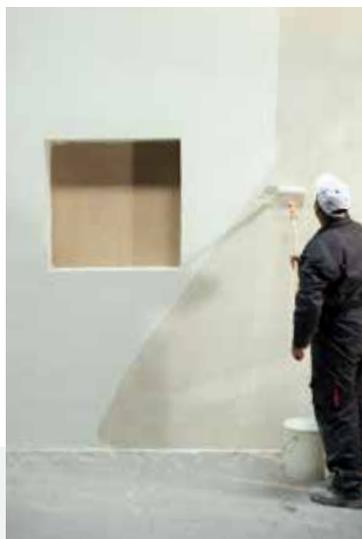
La natura del primer - che ha una funzione di ponte d'aderenza - deve essere compatibile con la tipologia di finitura-rivestimento colorato secondo le istruzioni del produttore del sistema (Figura 72).
