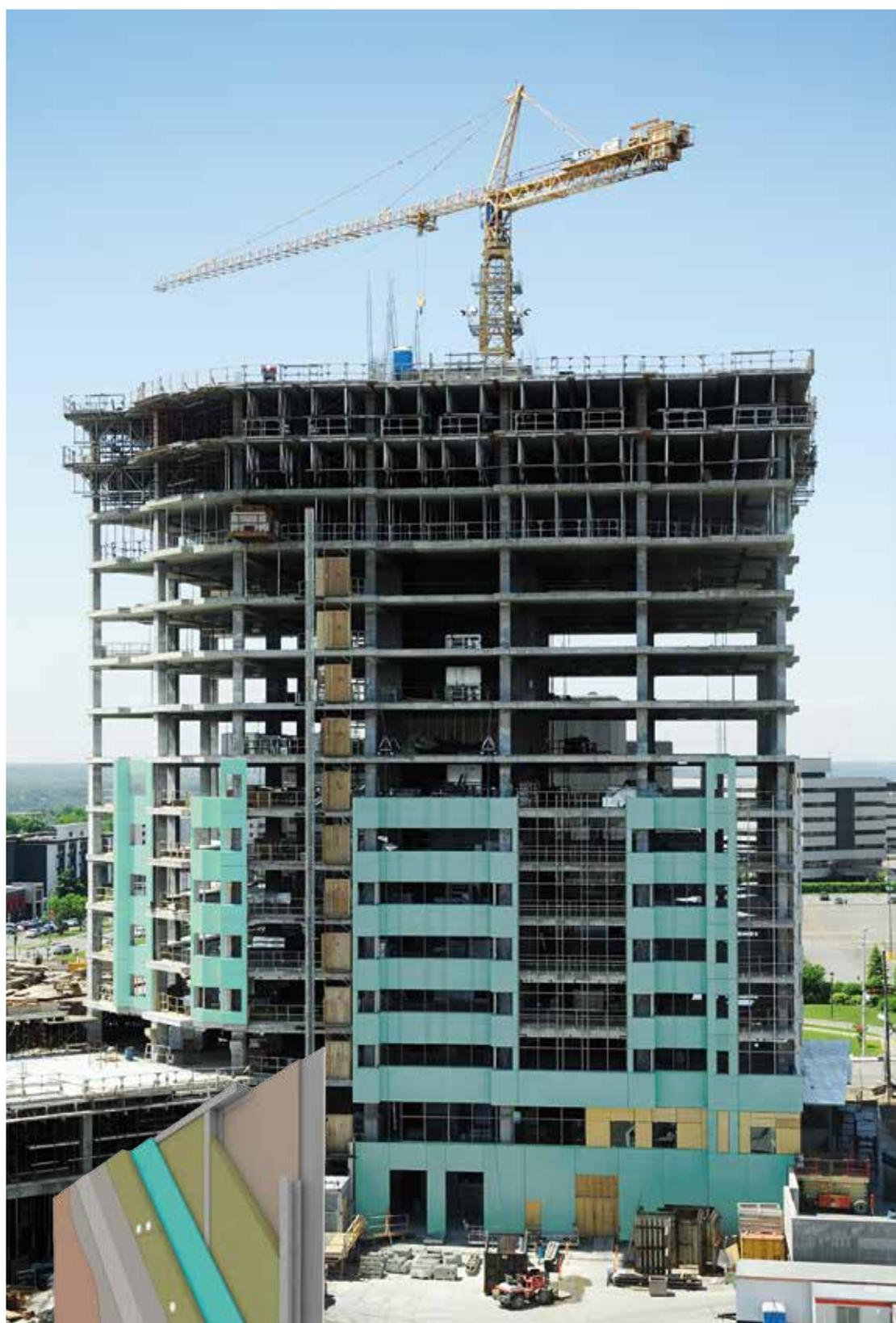
La lastra, marcata CE tipo **GM-H1-R** secondo la normativa EN 15283-1, ha ottenuto la classificazione europea di incombustibilità A1 al fuoco e risponde anche ai severi requisiti americani della ASTM C1177 "Regolamenti per lastre con finitura superficiale in fibra di vetro utilizzate come rivestimento esterno".
