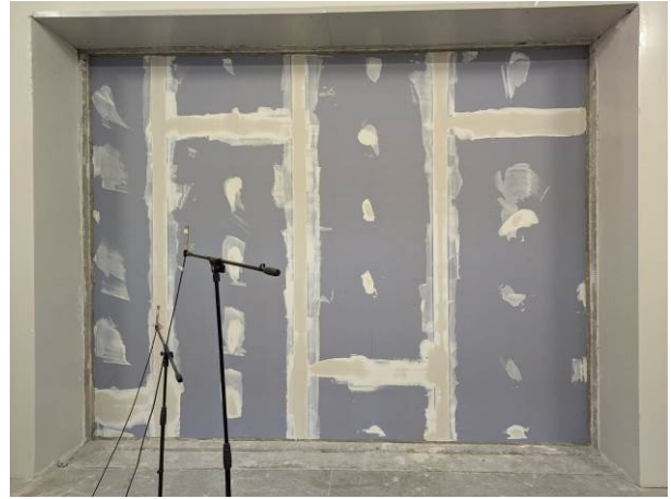
Lato sorgente / Source side
