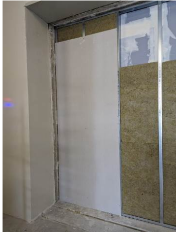
Lato sorgente / Source side
