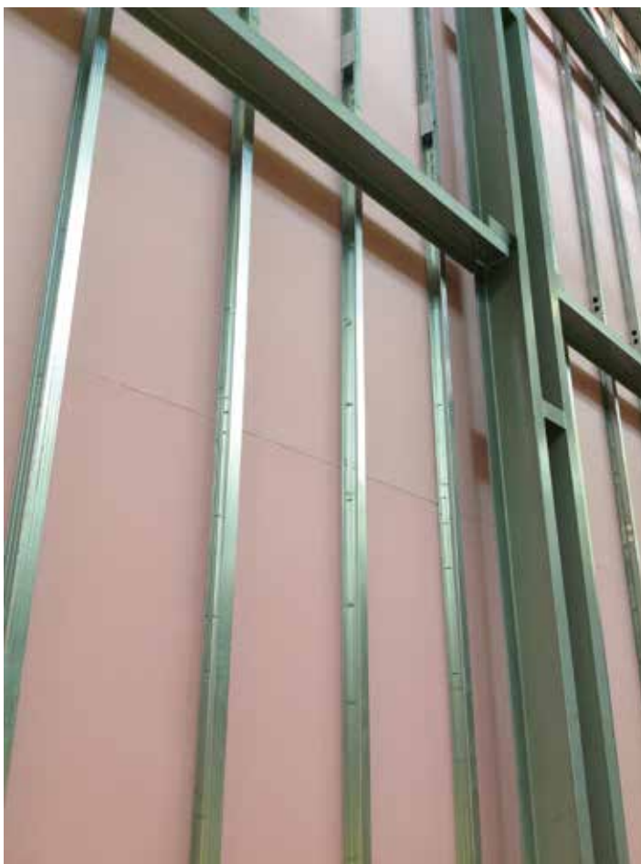
Particolare di compartimentazione antincendio con lastre FIBRANGyeps F e struttura FIBRANprofiles
