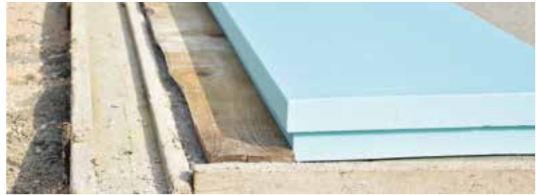
Magro realizzato con una miscela di calcestruzzo fine per evitare danni alla superficie dei pannelli.
