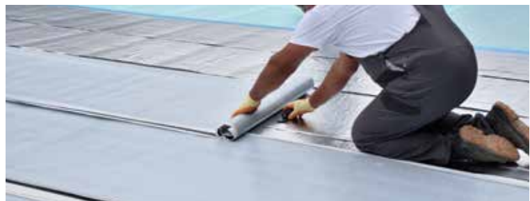
Posa dell'impermeabilizzazione biadesiva FIBRANhydro SEISMIC T-1,8sk/sk (in figura sull'eventuale primo strato tipo FIBRANhydro ANTI RADON 1,5sk) con un'opportuna sovrapposizione e lo stesso orientamento dell'eventuale primo strato; rimuovere con gradualità il film protettivo in silicone dalla faccia inferiore della membrana biadesiva.
