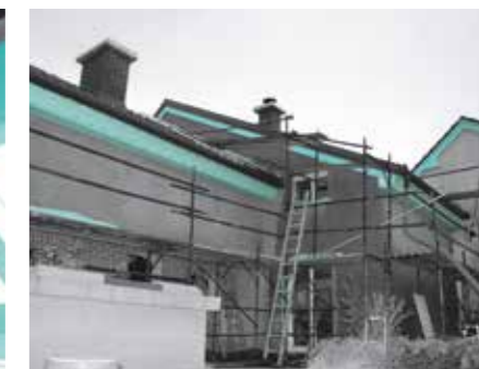
Sporti di gronda realizzati con pannelli FIBRANxps ETICS . Lo spessore dipende dalla luce.
