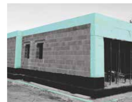
Isolamento di ponti termici, connessioni antisismiche e travi portanti con pannelli FIBRANxps ETICS .
