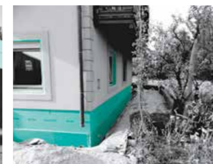
Isolamento termico dei ponti termici delle spallette e della zoccolatura con pannelli FIBRANxps ETICS .
