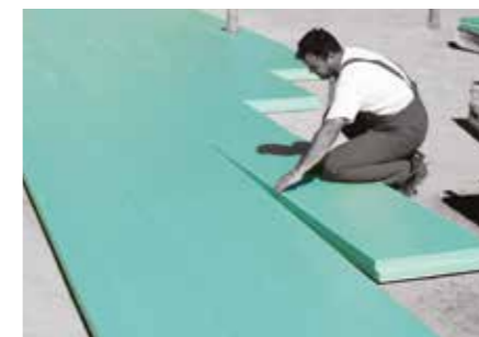
Prima di realizzare il magro di fondazione e posare il primo strato di isolamento termico FIBRANxps ( 400-L, 500-L, 700-L ), prestare particolare attenzione al passaggio delle tubazioni di servizio.
