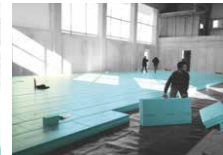
Posa in opera di pannelli termoisolanti FIBRANxps 500-L sotto la fondazione a platea.
