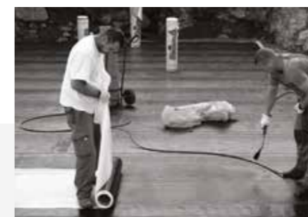
In presenza di falda acquifera e/o terreni poco permeabili, l'impermeabilizzazione viene realizzata in due strati: la membrana impermeabilizzante autoadesiva FIBRANhydro T-3 sk come primo strato e la membrana impermeabilizzante biadesiva FIBRANhydro SEISMIC T-1,8 sk/sk sulla prima.
