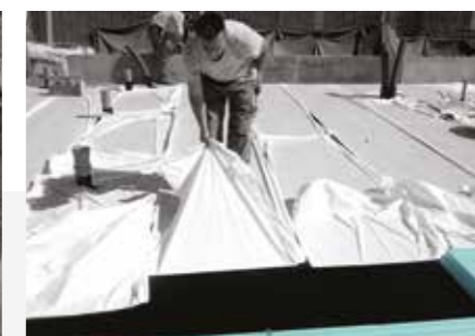
La pellicola protettiva presente sulla faccia superiore della membrana biadesiva FIBRANhydro SEISMIC T-1,8 sk/sk viene pelata progressivamente.
