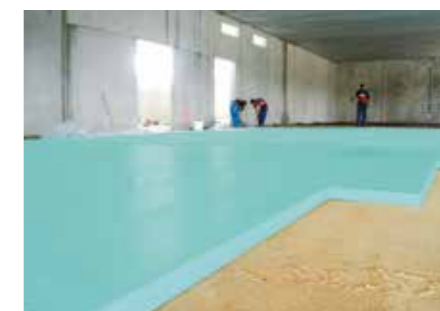
Isolamento termico con FIBRANxps 300-L del pavimento di un magazzino.
