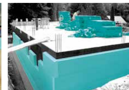
Pannelli isolanti FIBRANxps 300-L (resistenti meccanicamente e impermeabili) hanno funzione di protezione meccanica dello strato impermeabilizzante e d'isolamento termico della struttura interrata, anche nel caso di un livello alto della falda idrica.
