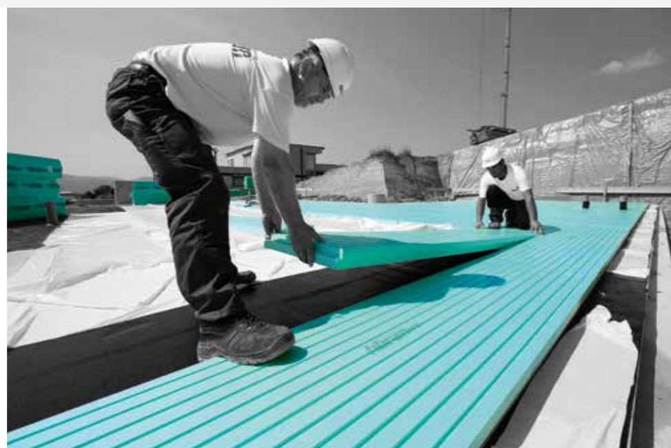
I pannelli FIBRANxps SEISMIC vengono posati con precisione estrema sulla superficie superiore adesiva della membrana FIBRANhydro SEISMIC T-1,8 sk/sk .
