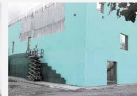
Pannelli FIBRANxps MAESTRO in intercapedine mentre viene eseguito il paramento esterno di facciata con cemento a vista.
