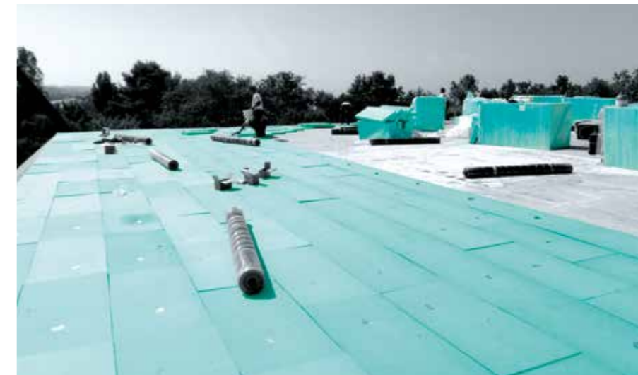
Aumento della pendenza e risanamento dell'isolamento termico di un tetto piano con pannelli FIBRANxps INCLINE .
