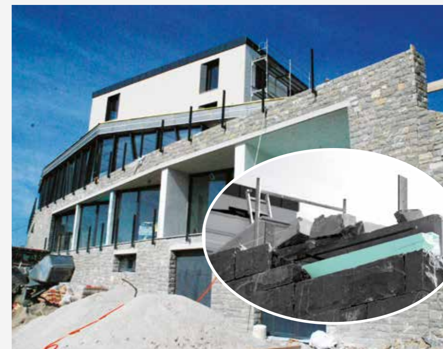
Facciata in pietra naturale di un albergo realizzata con pannelli portanti FIBRANxps ETICS BT-I sui quali è stato applicato il rivestimento pesante.
