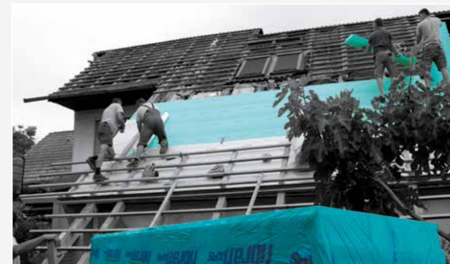
Trasformazione di un sottotetto in una mansarda abitabile realizzata con la membrana riflettente FIBRANskin VENT SILVER ed i pannelli termoisolanti FIBRANxps MAESTRO .
