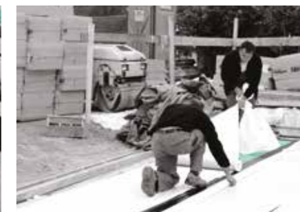
La membrana impermeabilizzante biadesiva FIBRANhydro SEISMIC T-1,8sk/sk viene posata sul primo strato di pannelli isolanti termici FIBRANxps, di spessore e resistenza termica conformi ai requisiti di progetto.
