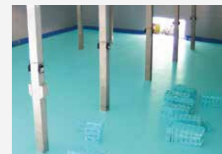
Isolamento termico del pavimento di una cella frigorifera con pannelli FIBRANxps 500-L, 700-L.
